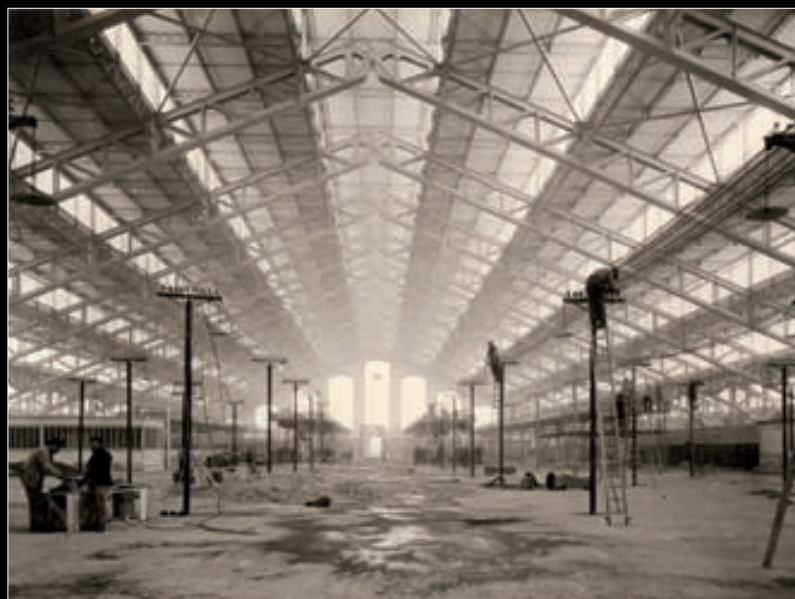
Rare album photo sur l'installation d'une usine électrique dans la halle Tony Garnier en 1915
