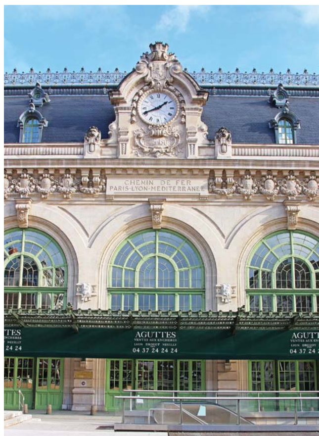
Aguttes à Lyon
