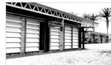
Écoles industrialisées du Cameroun et logements de fonction. Façades brise-soleil conçues par Jean Prouvé
